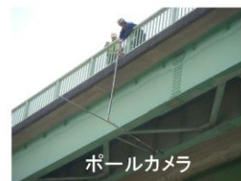
外観目視調査
