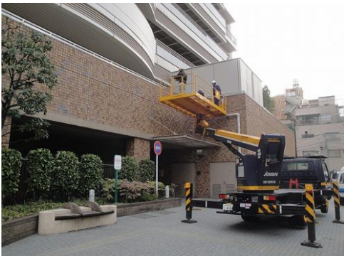
外壁タイルの打音検査
