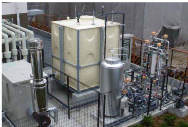
高度な膜処理技術により、要求される水質を満たします。また、深層地下水を採取することで地盤沈下の問題も無く、水量も安定し、干ばつによる井戸枯れの心配もありません。
