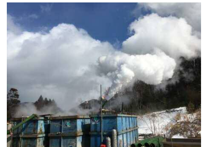
地熱発電のための生産井能力試験状況
