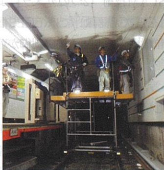
軌道内天井コンクリート打診調査
