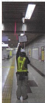
天井仕上材突上げ調査
