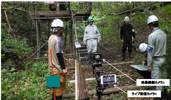
ボーリング地点での Web カメラ検尺の実施状況写真
