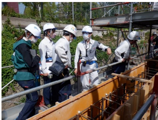
施工見学会の様子
