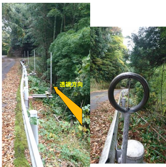
のぞき窓から地形の異変（地面のズレ）が分かる「見通し棒」
