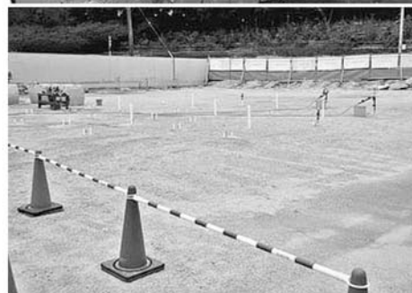
原位置浄化の事例。上から順に浄化剤攪拌、土壌ガス吸引、フェントン工法。
